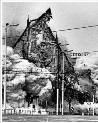
... und bei der Sprengung am 30. Mai 1968. Foto: epd
